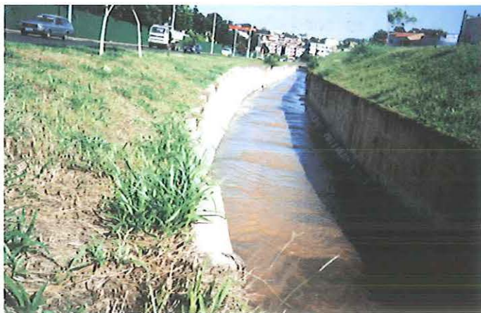
Figura 27: Canalização do córrego do Tijuco Preto (Março/2002, Elias T. Matsuo).
