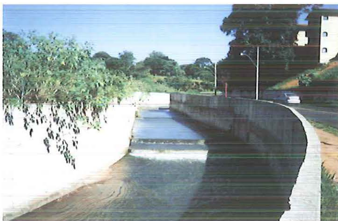
Figura 28: Canalização do rio do Monjolinho (Março/2002, Elias T. Matsuo).
