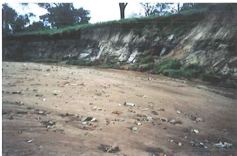
Figura 31: Assoreamento e erosão da margem do córrego da Água Quente (Março/2002, Elias T. Matsuo).
