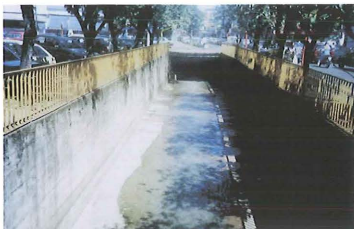
Figura 29: Canalização do córrego do Gregório (Março/2002, Elias T. Matsuo).
