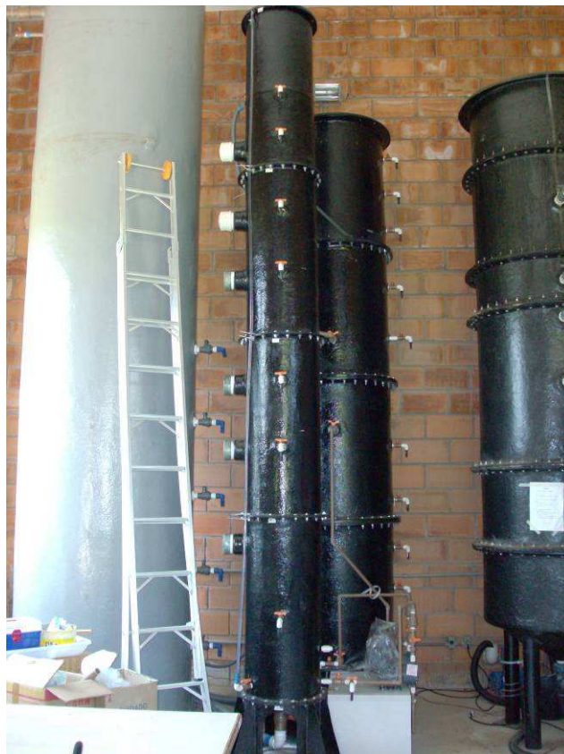
Figura 4.19 – Vista do sistema DANDE completamente montado, ao centro.
