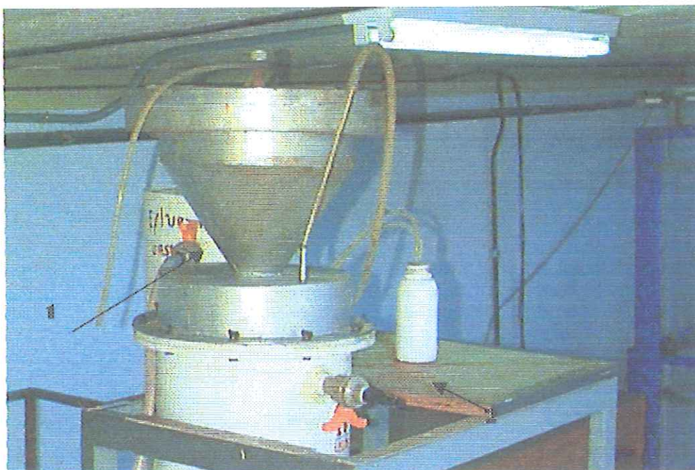
Figura 8 – Separador de fases do UASB.
