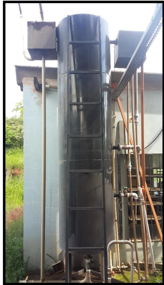
Figura 4- UASB Cilíndrico Projetado (Adaptado SILVA, 2014)
