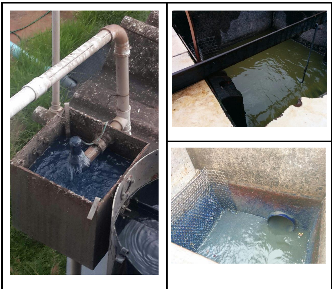
Figura 11 - Esgoto afluente à ETE USP São Carlos com cor não característica de esgoto doméstico
