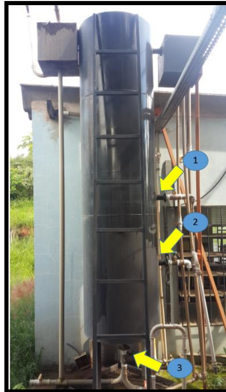
Figura 16 - Pontos de coleta de lodo no reator UASB. (1) Ponto mais alto, usado para verificar a altura da manta de lodo. (2) Ponto de coleta intermediária. (3) Ponto de coleta de no fundo do reator.
