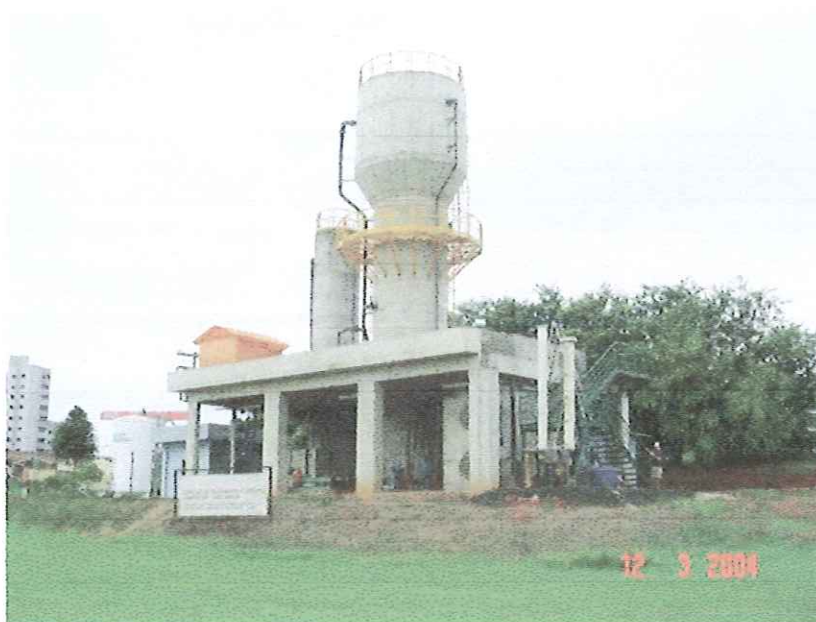
Figura 4-2: Vista da estação de tratamento de esgoto da USP - São Carlos.
