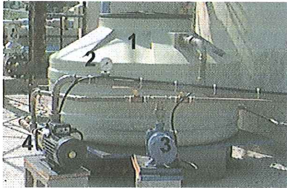
Fotografia 16 – Reservatório do afluente da ozonização (1 – reservatório, 2 – manômetro, 3 – bomba 1, 4 – bomba 2).
