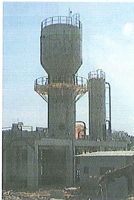
Fotografia 17 – Reator anaeróbio de leito expandido, usado em pesquisa na EESC-USP. (MENDONÇA, 2003)
