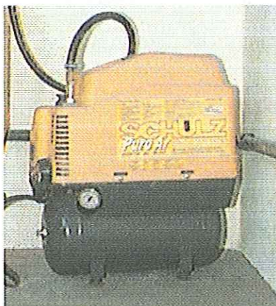
Fotografia 12 – Compressor para aeração do reator biológico aeróbio.
