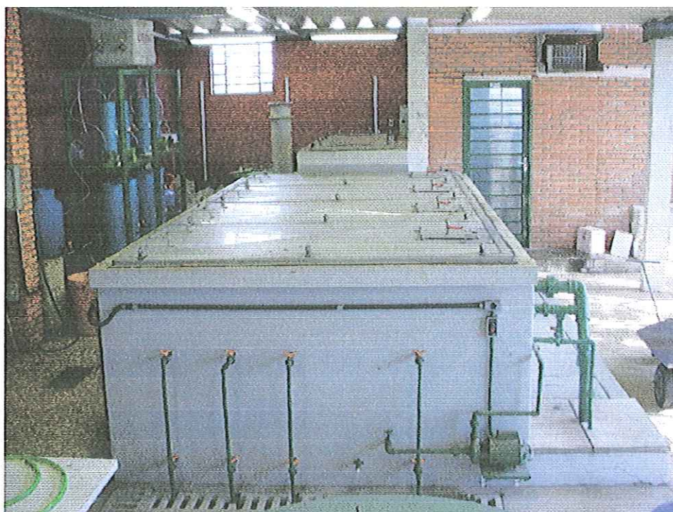
Fotografia 2 – Reator anaeróbio compartimentado
