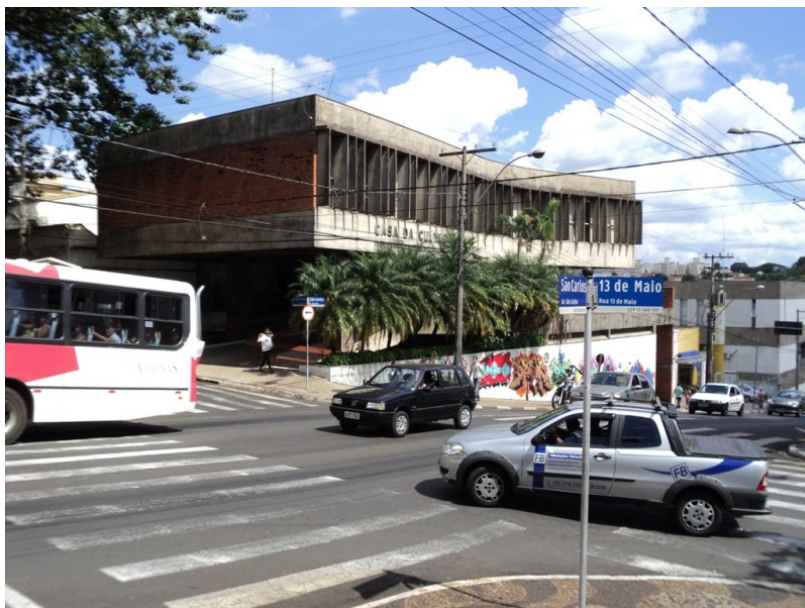
Figura 1. Fachada externa do prédio no cruzamento da Av. São Carlos com a Rua 13 de Maio.
