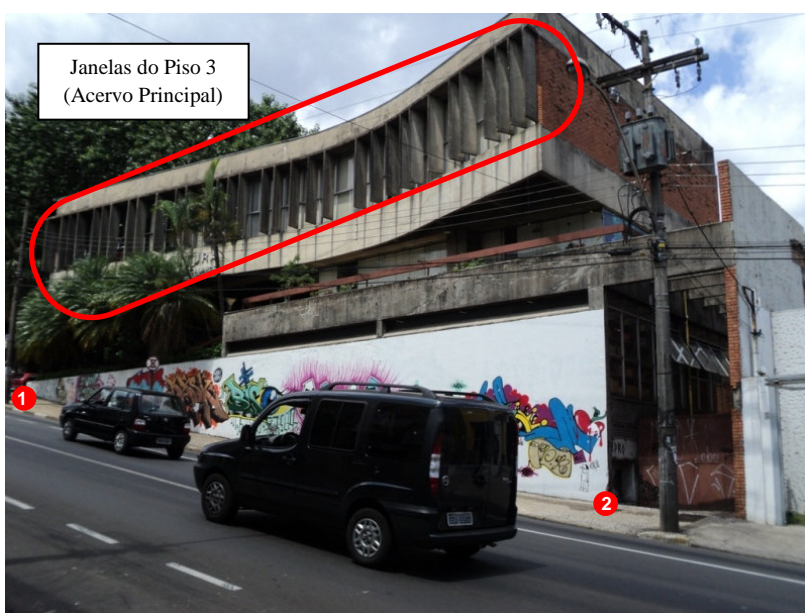
Figura 2. Fachada externa do prédio, vista por quem transita na Av. São Carlos; em destaque, as janelas do Acervo Principal e dois pontos de observação.
