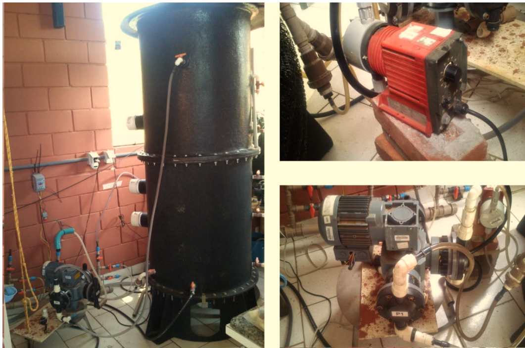
Figura 4.2 – O reator e as bombas utilizadas.
