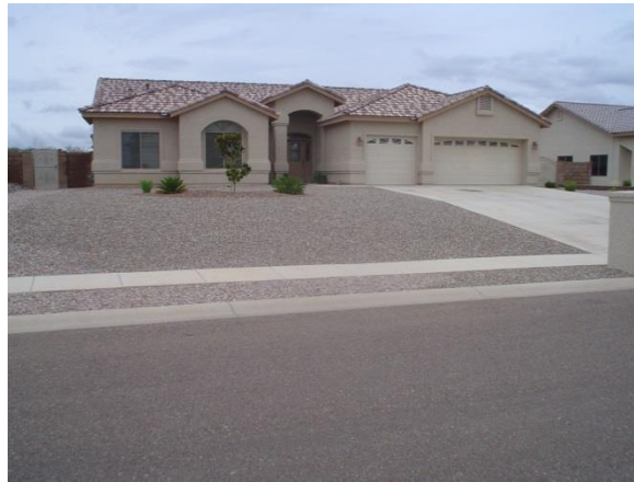
Figura 40 – Trecho permeável existente entre as calçadas e ruas.
