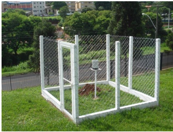
Figura 53 – Instalação em campo do pluviômetro de balança.
