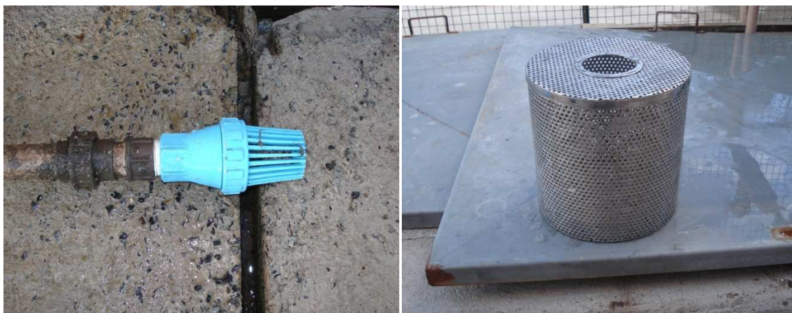
Figura 4.10 – Válvula de pé e crivo e cesto de aço inoxidável
