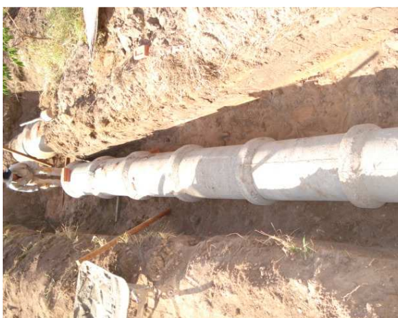
Assentamento das manilhas de concreto
