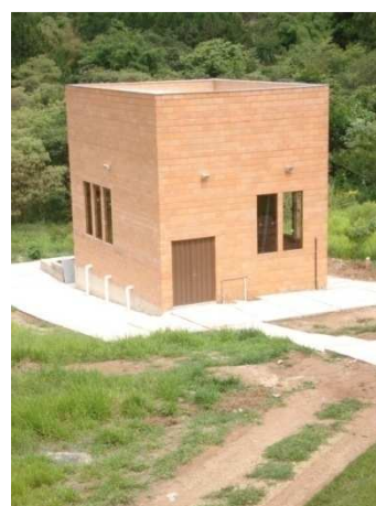
Área de tratamento de esgoto do LPB
