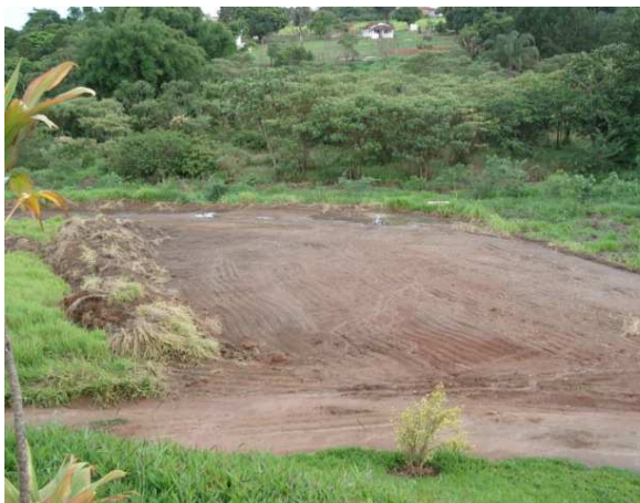
Preparação do terreno
