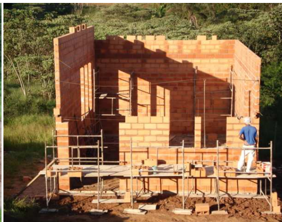
Levantamento da alvenaria
