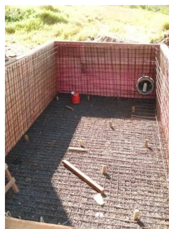
Armação da ferragem do reservatório de armazenamento
