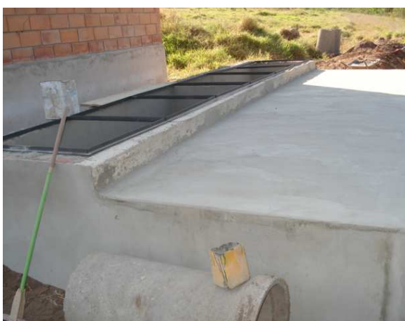
Reservatório em concreto armado
