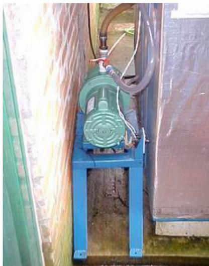
**Figura 5.39 – Bomba de recirculação colocada para fora da cabine antes da introdução do PCP no reator A.**
