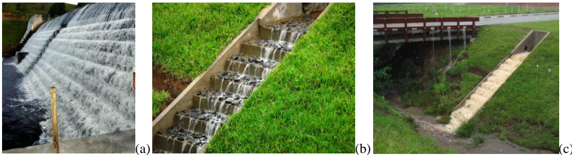
Figura 7.2 – Canais em degraus: (a) Barragem Rio da Dona (Imagem cedida por Antônio Gilberto Simões de Oliveira) e (b e c) canal dissipador de energia do sistema de drenagem do Campus II da USP – São Carlos.
