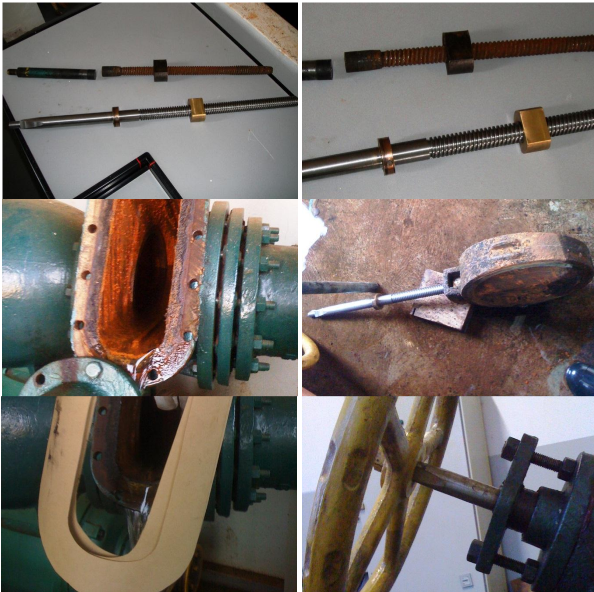
Figura A1.27 – Substituição da haste da válvula principal situada a jusante do conjunto motor-bomba: as duas primeiras fotografias mostram a haste antiga e a haste nova. As duas seguintes são fotos da válvula aberta e da haste nova presa ao disco. A penúltima fotografia mostra o papel utilizado para vedação e a última a válvula pronta para o uso com a sua nova haste.
