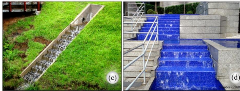
Figura 2.2 – Exemplos de canais em degraus com rugosidades superficiais diferentes: (a) Imagem aérea de um canal em degraus formado por rochas, situado no Canadá e pertencente ao James Bay Project; (b) Canal em degraus formado por gabiões; (c) Canal em degraus com rugosidades dos pisos modificada pela introdução de pedras; (d) Canal em degraus de uma estrutura decorativa, com a superfície revestida com pastilhas.
