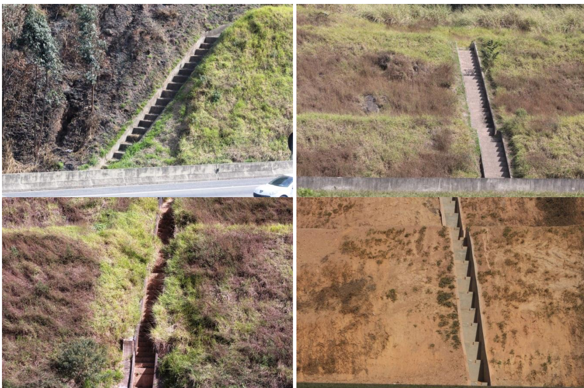
Figura A1.30 – Canal em degraus utilizado no sistema de drenagem do Campus II da USP em São Carlos. Nota-se que há uma entrada lateral e pedras incrustadas nos pisos. As duas últimas fotografias foram obtidas em 03/04/2010, às 18 h, aproximadamente. Nota-se que o escoamento ocorre em quedas sucessivas e com grande quantidade de ar incorporado desde o início do canal.
