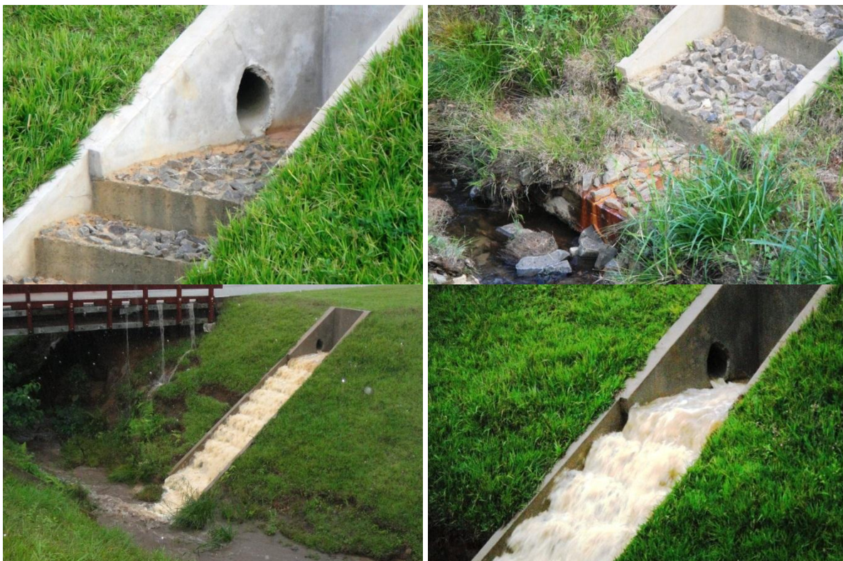
Figura A1.30 – Canal em degraus utilizado no sistema de drenagem do Campus II da USP em São Carlos. Nota-se que há uma entrada lateral e pedras incrustadas nos pisos. As duas últimas fotografias foram obtidas em 03/04/2010, às 18 h, aproximadamente. Nota-se que o escoamento ocorre em quedas sucessivas e com grande quantidade de ar incorporado desde o início do canal.
