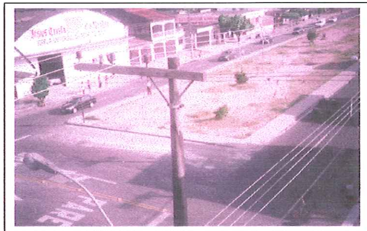
FIGURA 6.52 - Interseção da avenida Marques de Herval com a travessa Curuzú.
