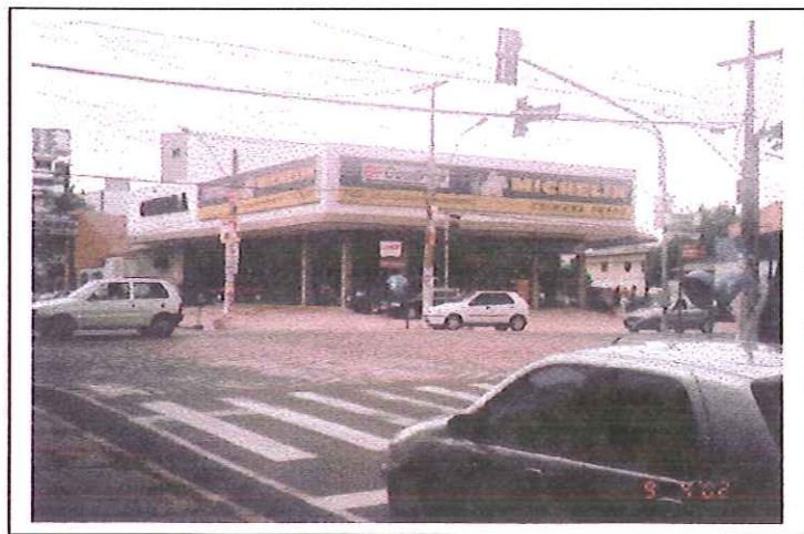
FIGURA 6.39 - Interseção da avenida Governador José Malcher com a travessa Nove de Janeiro.
