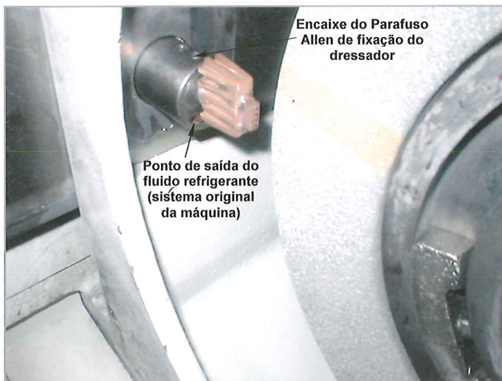
Figura 39: Detalhe da fixação do dressador aletado na retificadora.
