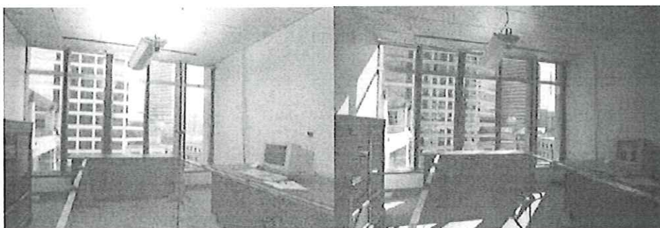
Figura 24 - Vidro eletrocrômico com transmitância total e transmitância parcial – retirado de (LEE, DIBARTOLOMEO e SELKOWITZ, 2004).
