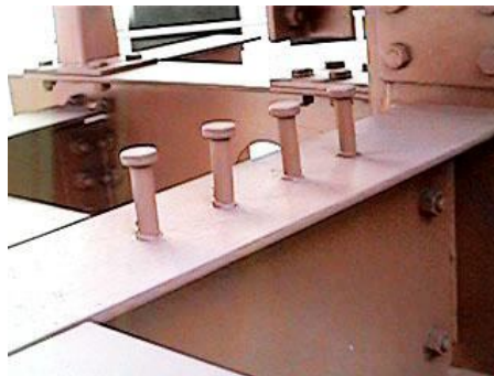
Figura 2.19 – Conector tipo pino com cabeça (ALVA, 2000)
