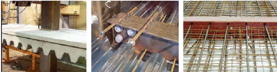
Figura 3.2 – Exemplos de pisos mistos de pequena altura (MALASKA, 2000 e QUEIROZ et al. , 1998)
