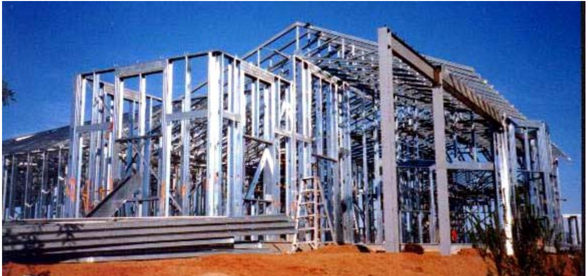
Figura 10 - Construção em STEEL FRAME < www.estruturametalia.com.br > acesso 14/12/2003
