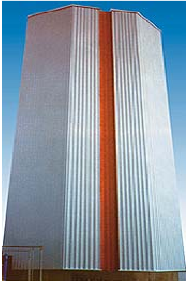
Figura 7 – Fachada <www.bemo.com.br acesso 16-09-2002>
