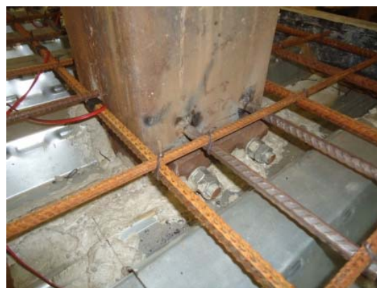
(b) Armadura do Modelo 3 fixada com luvas.
