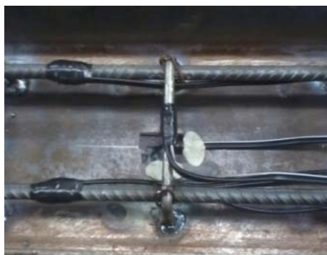
Figura 4.7 – Detalhe da instrumentação no Modelo 1
