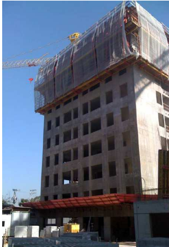
Figura 1-1 - Execução de edifício de parede de concreto armado (FONSECA JUNIOR-2009).
