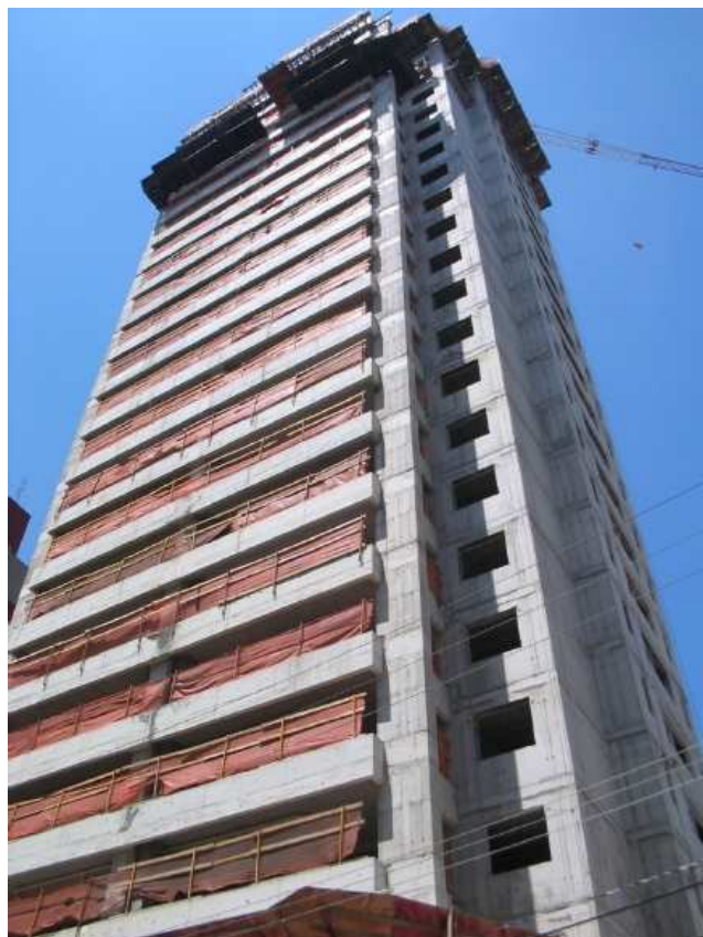
Figura 2-1 – Edifício Cullinan Itaim – São Paulo-SP.
