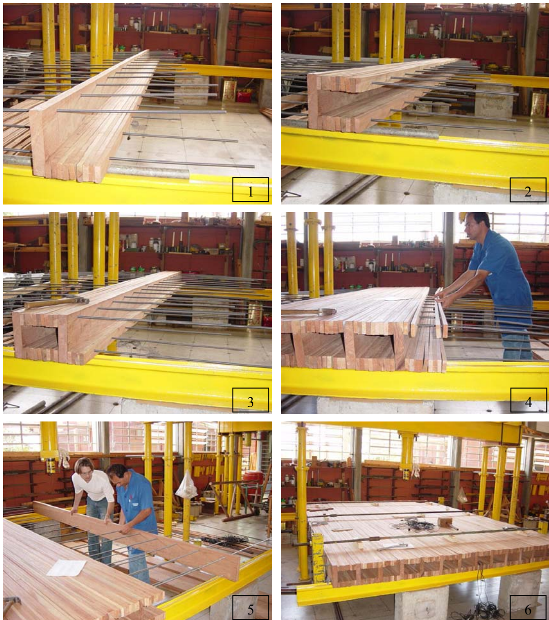
Figura 103 – Montagem do tabuleiro
