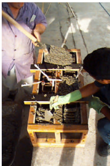
Figura 4.32. Pilares sendo concretados sobre mesa vibratória.
