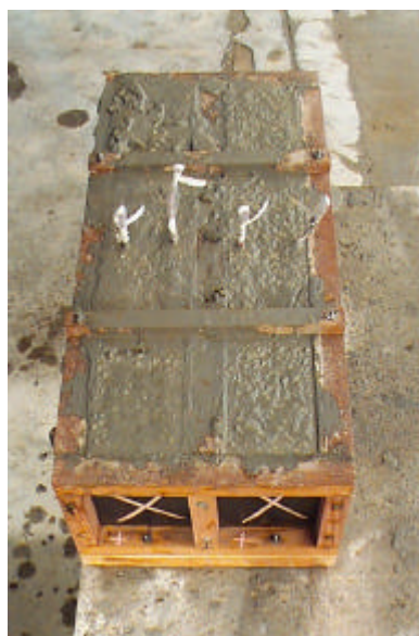
Figura 4.33. Pilares já concretados e à espera do serviço de acabamento.
