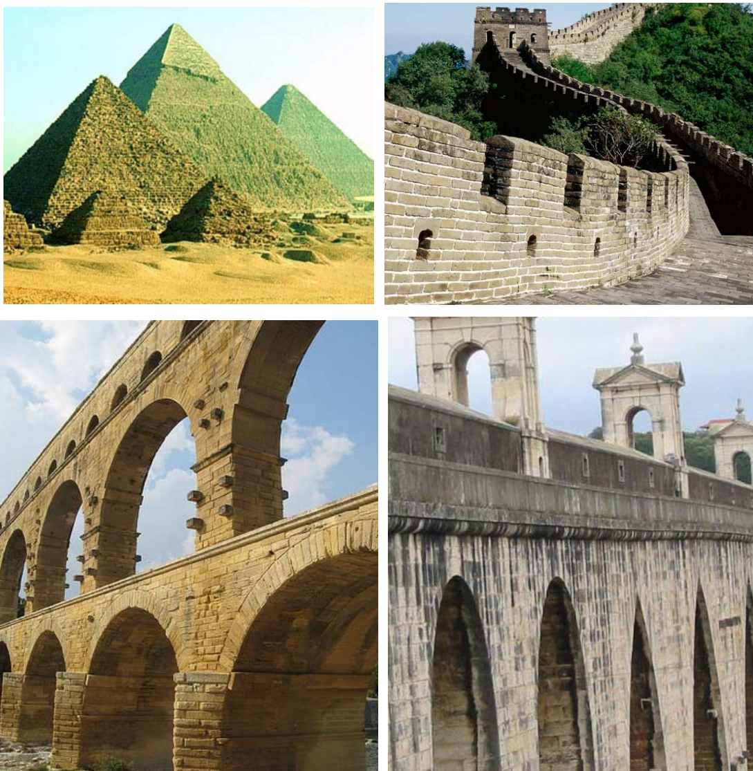
Figura 1.1 – Exemplos de construções íntegras de alvenaria na antigüidade
