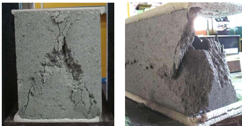
Figura 4.2 – Ruptura dos blocos à compressão
