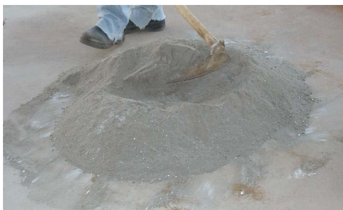
Figura 3.12 – Confeção da argamassa de forma manual
