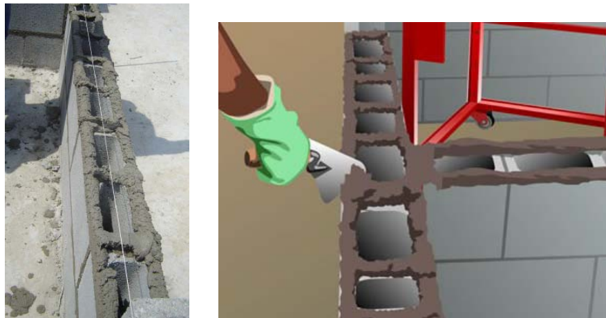
Figura 2.6 – Argamassamento total. (RAMALHO, 2009), ( http://www.selectablocos.com.br/ )
