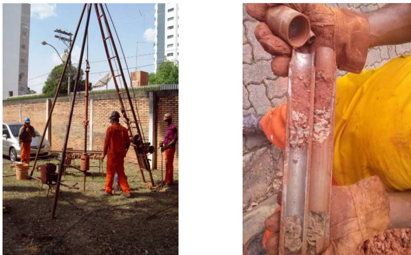
Figura 39: Equipamentos utilizados nos ensaios SPT
