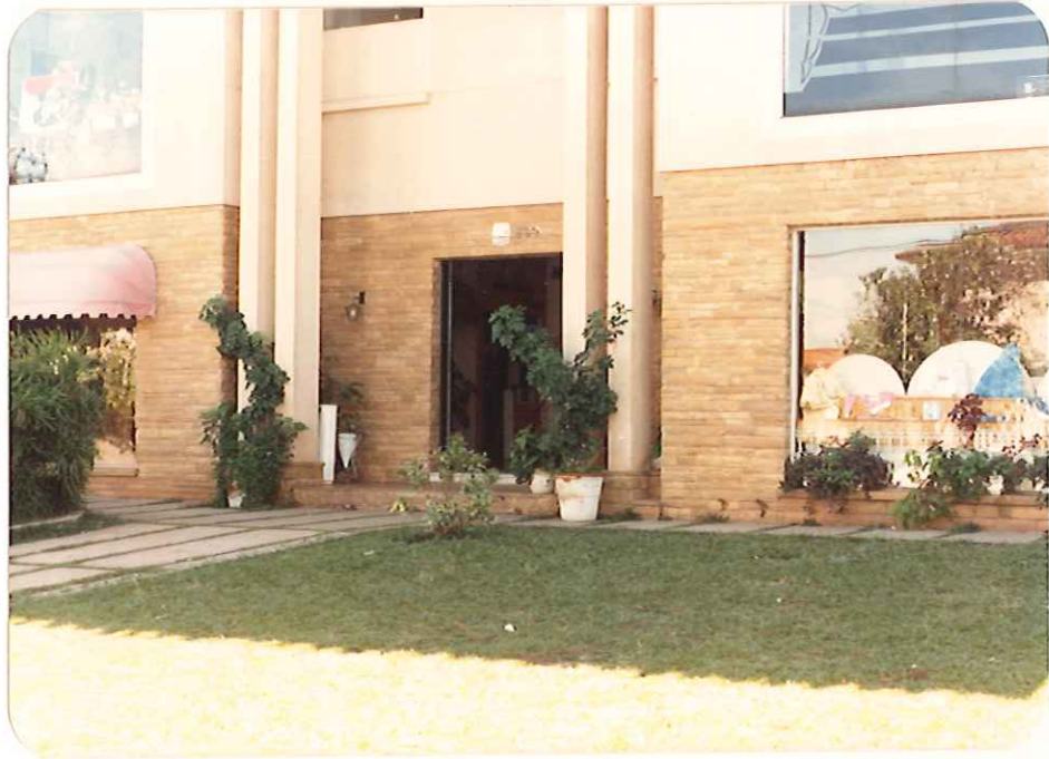
Figura 5.5: Lajes com aparelhamento manual perpendicular ao acamamento. Fachada de residência em São Carlos.
