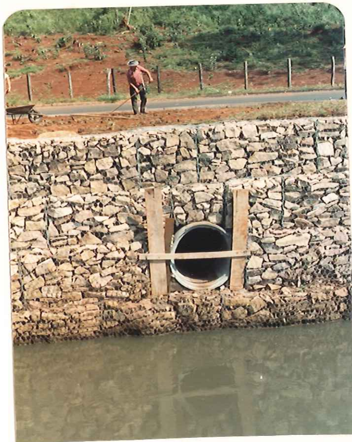
Figura 5.3: Estrutura de arrimo em gabião preenchido com fragmentos irregulares de arenito silicificado, usado na retificação do Corrego do Monjolinho. São Carlos.
