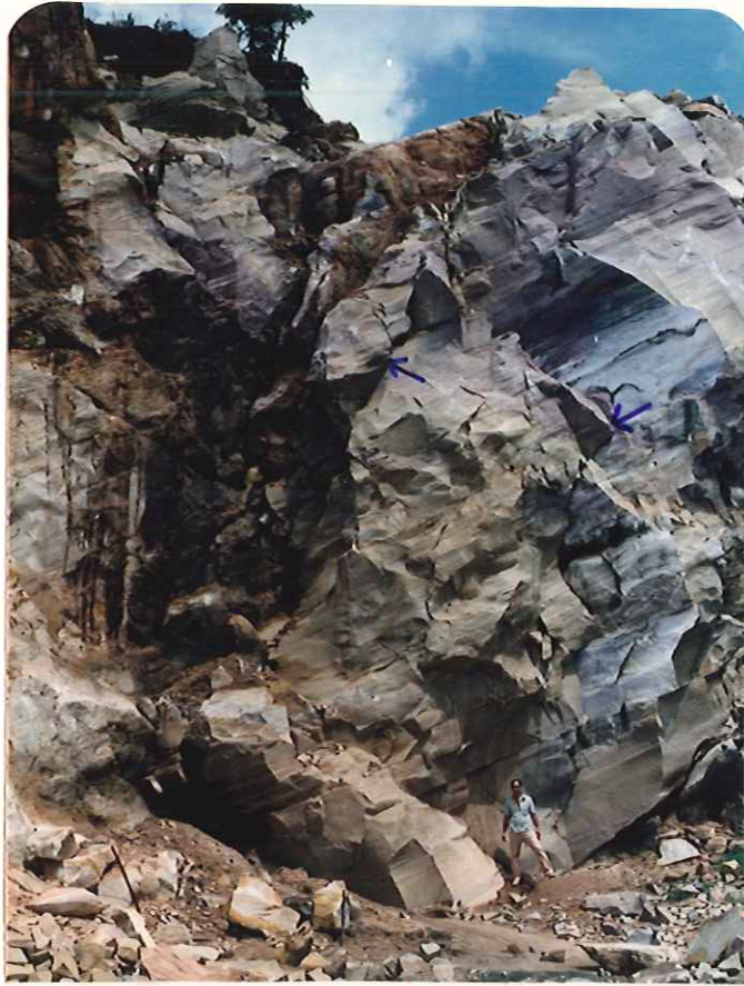
Figura 3.13: Fraturas e brechas ("destaques") aproveitadas para desmonte de blocos. As setas indicam algumas delas. Pedreira Garcia. Município de São Carlos.
