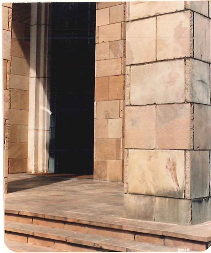
Figura 5.4: Aplicações de arenito: Lajes aparelhadas manualmente (coluna) e lajes polidas com bordas serradas (piso e escadaria). Catedral de São Carlos.
