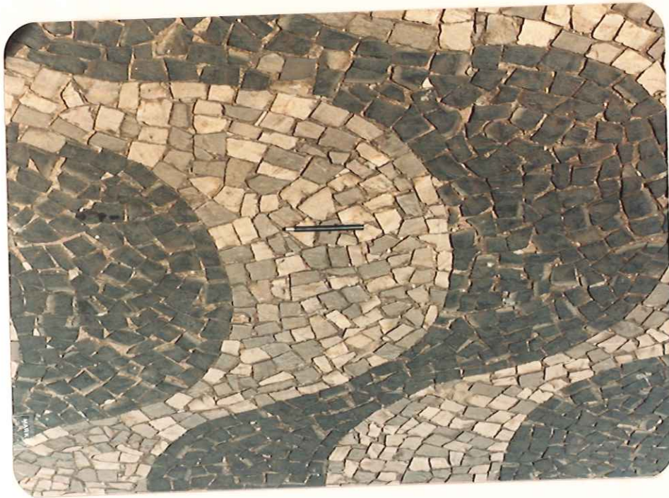
Figura 5.2: Aplicação de arenito como "petit-pavé", juntamente com basalto. Catedral de São Carlos.
