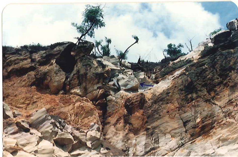
Figura 3.14: Extração de blocos na Pedreira Garcia no Município de São Carlos. A seta indica bloco descalçado pronto para ser tombado na praça
