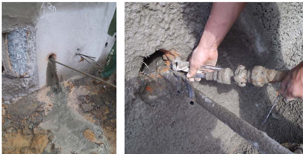
Figura 3.28. Execução da Bainha (a) e Procedimento de injeção (b).
