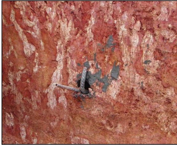
Figura 2.9. Extremidades do grampo dobrada.
