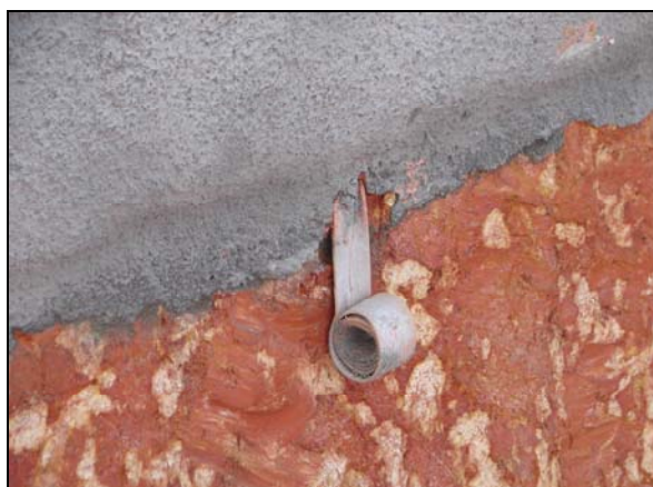
Figura 2.11. Dreno de Paramento tipo Linear – Geodreno.
