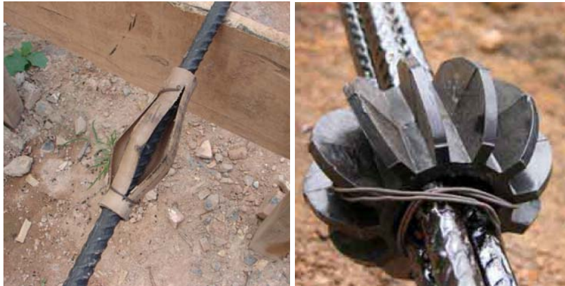
Figura 2.6. Detalhe de centralizador instalado em grampo.
