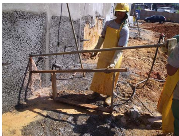
Figura 3.26. Controle da inclinação do chumbador com gabarito.
