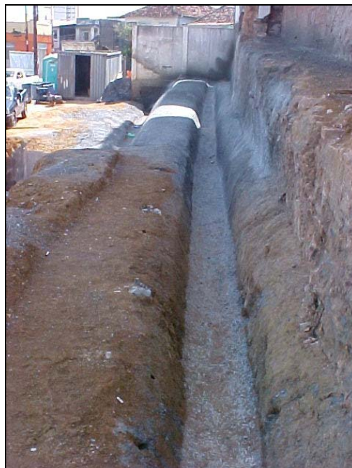
Figura 2.13. Detalhe de Canaleta para Drenagem.
