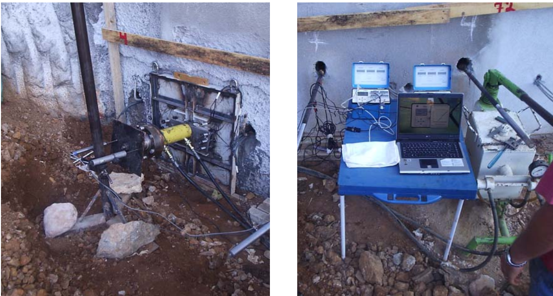
Figura 3.29. Sistema de arrancamento dos chumbadores (a) e Sistema de aquisição automática dos dados (b).
