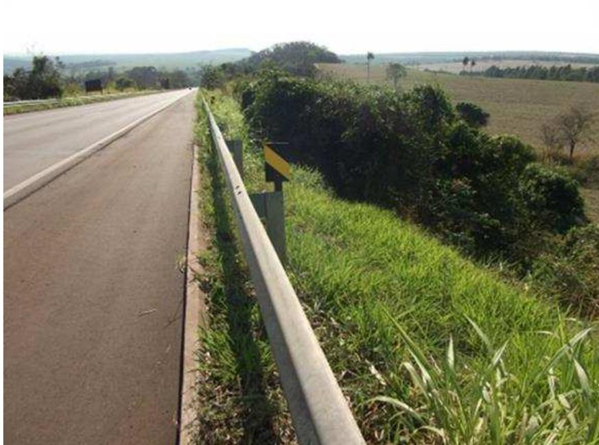
Figura 29-Foto do ponto P14 correspondente a um local de aterro cuja inclinação encontra-se maior que 30°, o que não é recomendado para aterros não reforçados.
