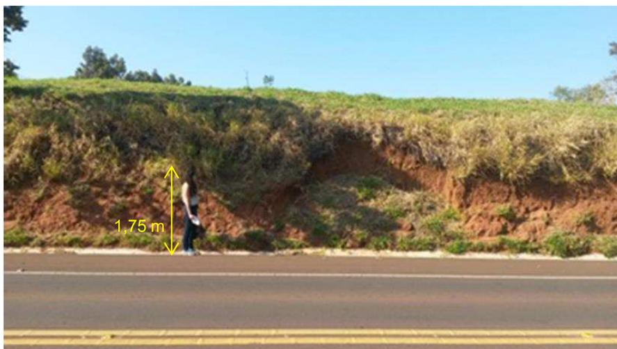
Figura 27 - Foto do ponto P1 exibindo cicatriz de escorregamento em solo residual da formação Adamantina.
