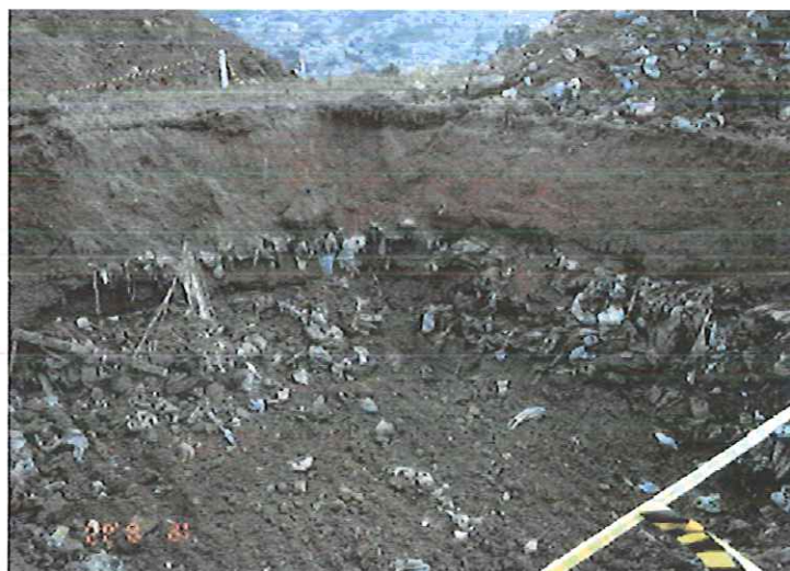
Figura 3.3. Inclinação dos taludes das valas abertas para amostragem das geomembranas.
