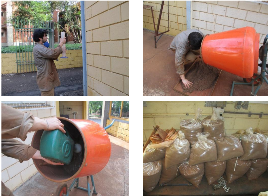
a. Adição da água necessária para atingir o teor de umidade ótimo
