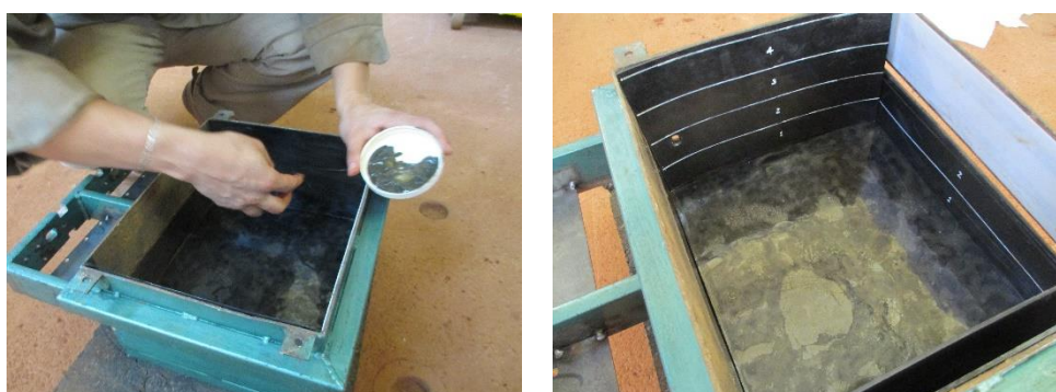
a. Aplicação da graxa na primeira geomembrana
