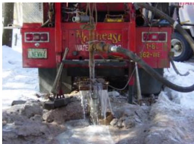
Figura 1.3 - Execução de fraturamento hidráulico em poço de água.
