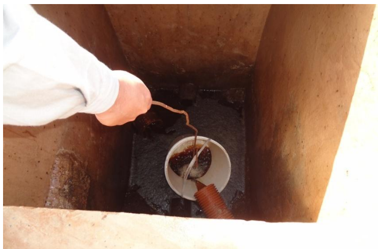
Figura 3.1 - Lixiviado sendo coletado da caixa de passagem no aterro sanitário de São Carlos
