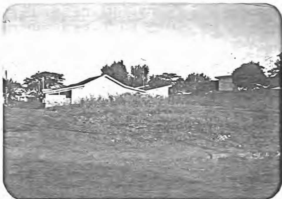
FIG. 45 - ÁREA ABANDONADA APÓS A DEMOLIÇÃO DE SEIS CASAS COM RISCO DE DESABAMENTO.
