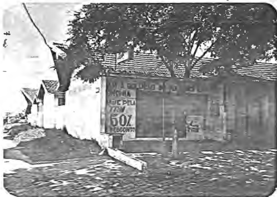
FIG. 36 - CASA TIPO 2R TRANSFORMADA EM AGÊNCIA DE VIAGENS.
