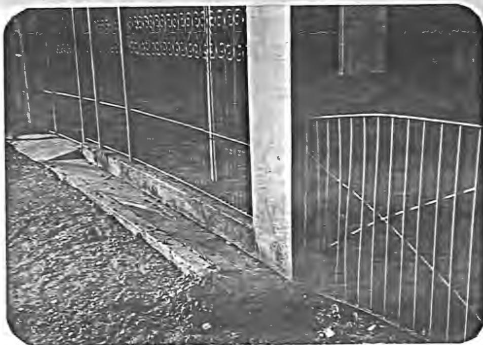
FIG. 38 - IMÓVEIS DO PASSEIO IMPERATRIZ COM AFUNDAMENTOS DOS PISOS PROVOCADOS PELO RECALQUE DIFERENCIAL.
