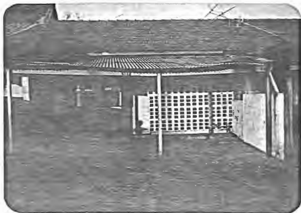
FIG. 31 - VISTAS QUE MOSTRAM O CAOS NAS FACHADAS DE CASAS TIPO 2 REFORMADAS OU NÃO.
