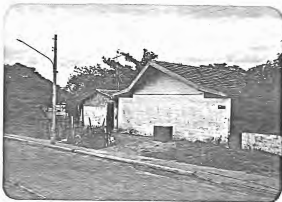
FIG. 33 - AMPLIAÇÃO FEITA NUMA CASA TIPO 2.
