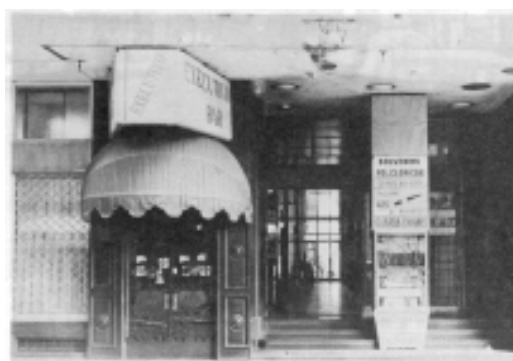
Fig. 266 - Detalhe da Entrada pela rua Sete de Abril, descaracterizada pelos acréscimos realizados pelo Bar Executivo. Fonte: DAHER, 1981.
