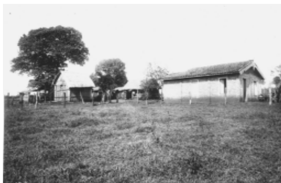
Fig. 27 - Casa do colono Angelo Capraro, construída no lote 31, do Núcleo Colonial Campos Salles. A fotografia foi tirada em 1907. Fonte: CMU/UNICAMP.
