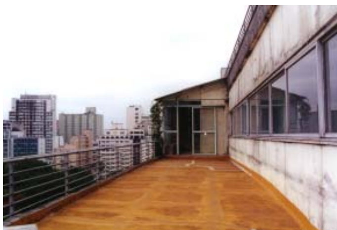
Fig. 236 - No sentido contrário ao da foto de 1938, vê-se o acréscimo de área no local originalmente ocupado pela divisória de vidro. Foto: F. Atique, 2001.
