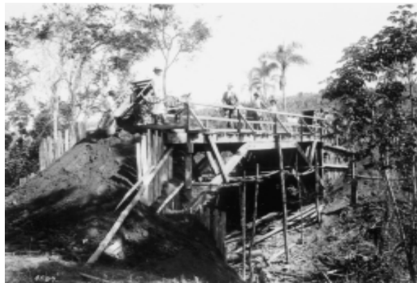
Fig. 30 - Construção de ponte, com madeira nativa, entre os lotes 111 e 112, do Núcleo Campos Salles. Primeira década do século XX. Fonte: CMU/UNICAMP.
