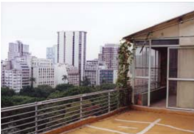
Fig. 244 - Vista externa do volume anexado à área original do apartamento 1102. Ao fundo, o arvoredo da Praça da República. Foto: F. Atique, 2001.
