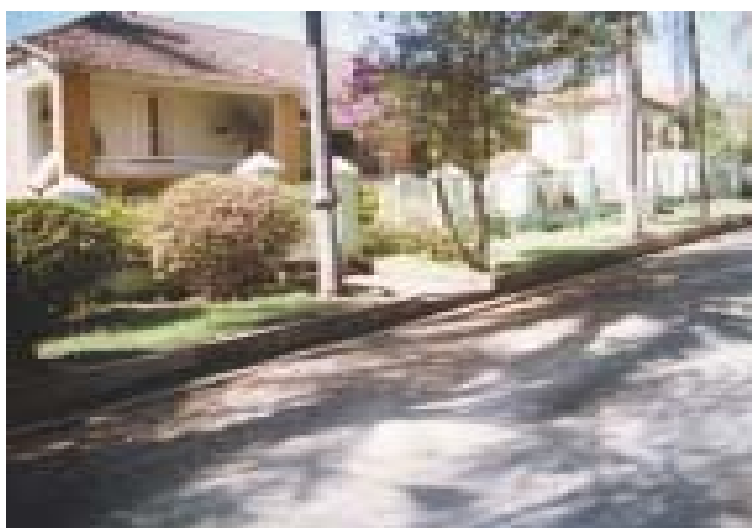
Fig. 69 a 72 - Aspectos da Vila dos Funcionários da Usina Esther. Ressalta-se o eclétismo da arquitetura das casas, indo de soluções com 'evocações normandas' a 'modernismos aaltianos'. Fotos: Philip Gunn, 1999.
