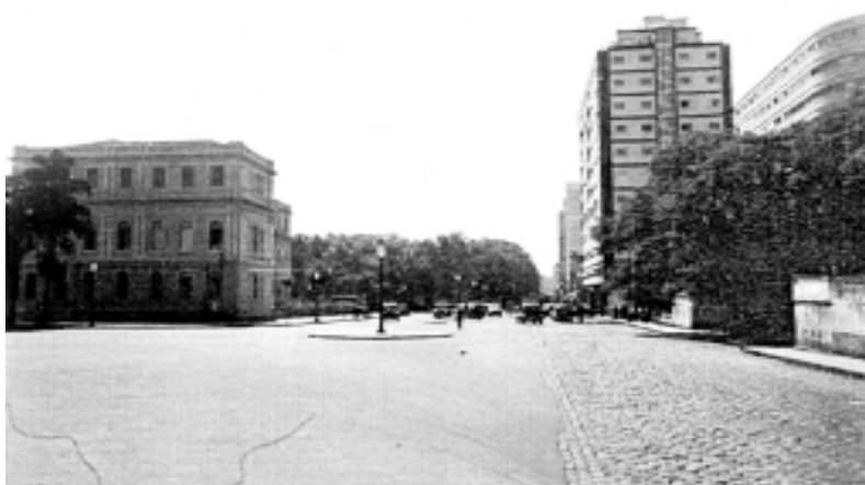
Fig. 186 - Foto da Avenida Ipiranga, em abril de 1939, um ano após a inauguração do Edifício Esther. Fonte: LEFÈVRE, 1999.
