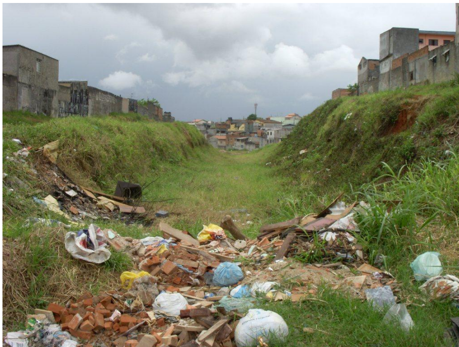
Foto 30 - Trecho da Adutora Rio Claro antes da implantação do parque: sem os cuidados de conservação: com lixo e mato
