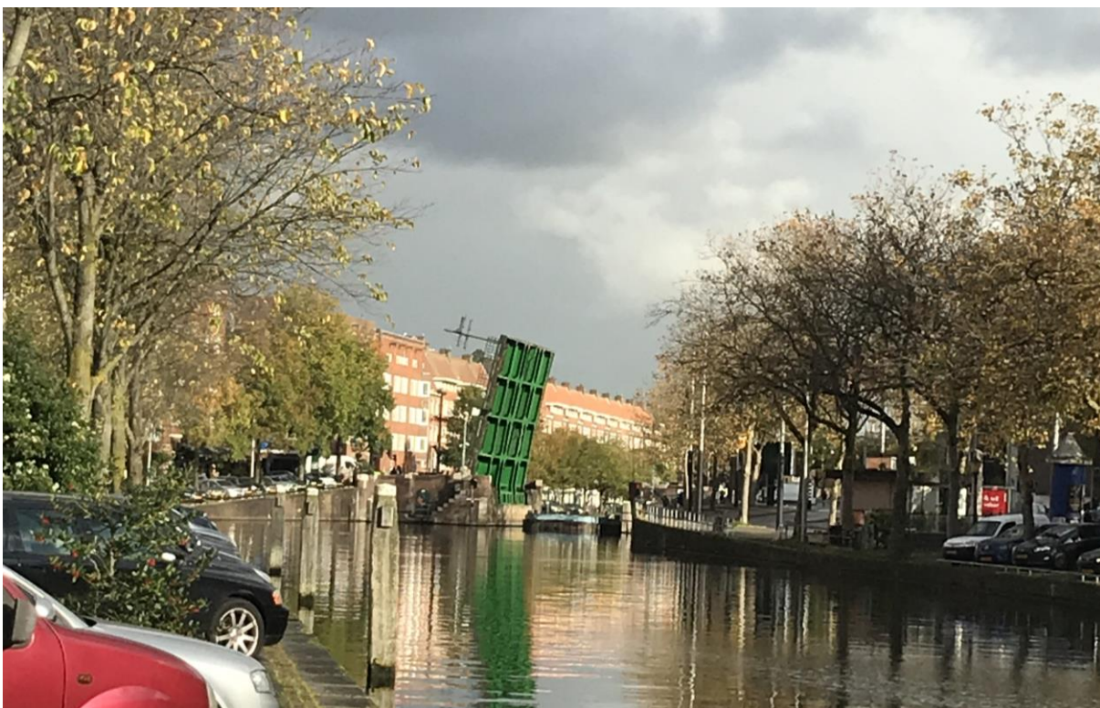
Figura 46. Ponte móvel sobre o Canal Schinkel, Amsterdã. Foto do autor, 2019.
