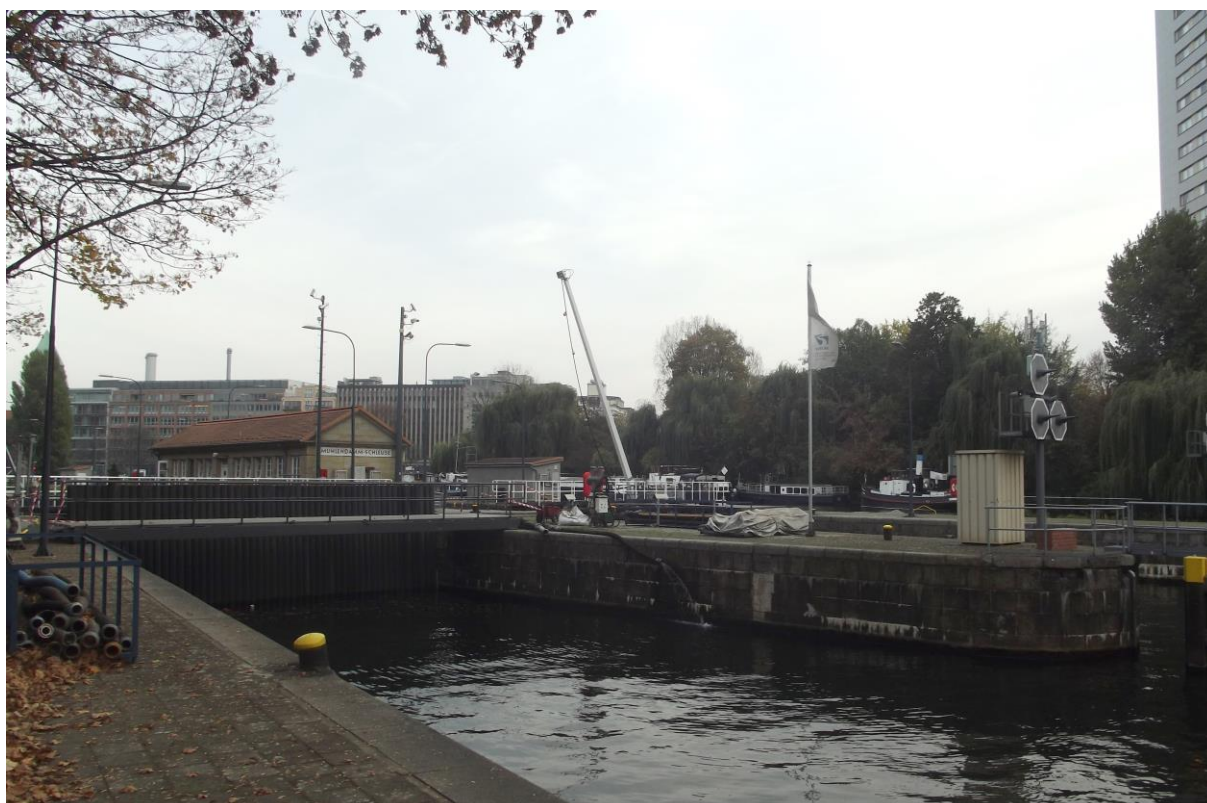
Figura 59: Vista da eclusa Mühlendamm Schleuse no rio Spree, em Berlim. Referência de eclusa de baixa queda hídrica. Fonte: Foto do autor, 2019.
