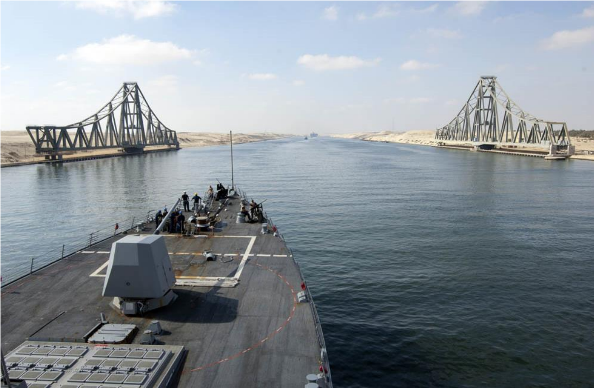
Figura 62: Ponte móvel regional, Canal de Suez. Canais de navegação regionais e de longo curso.
