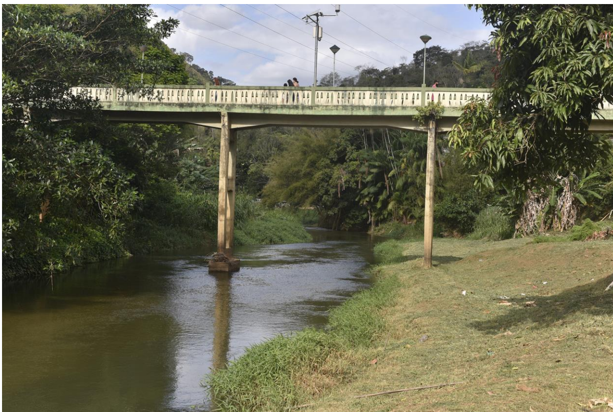
Figura 40: Ponte da rodovia ES-080 sobre o Rio Santa Maria da Vitória. Foto: Ricardo Medeiros.
