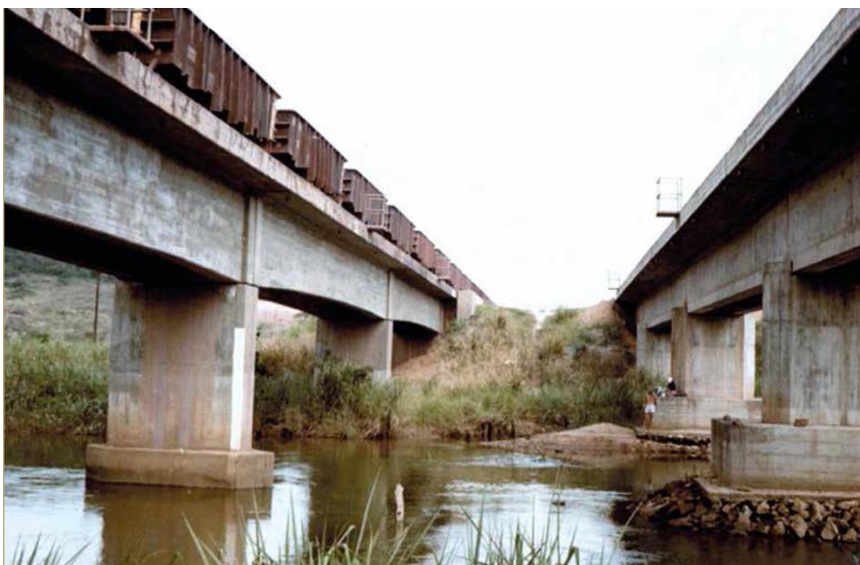
Figura 41: Pontes ferroviárias da EFVM sobre o Rio Santa Maria da Vitória. Fonte: CAUS, 2012.
