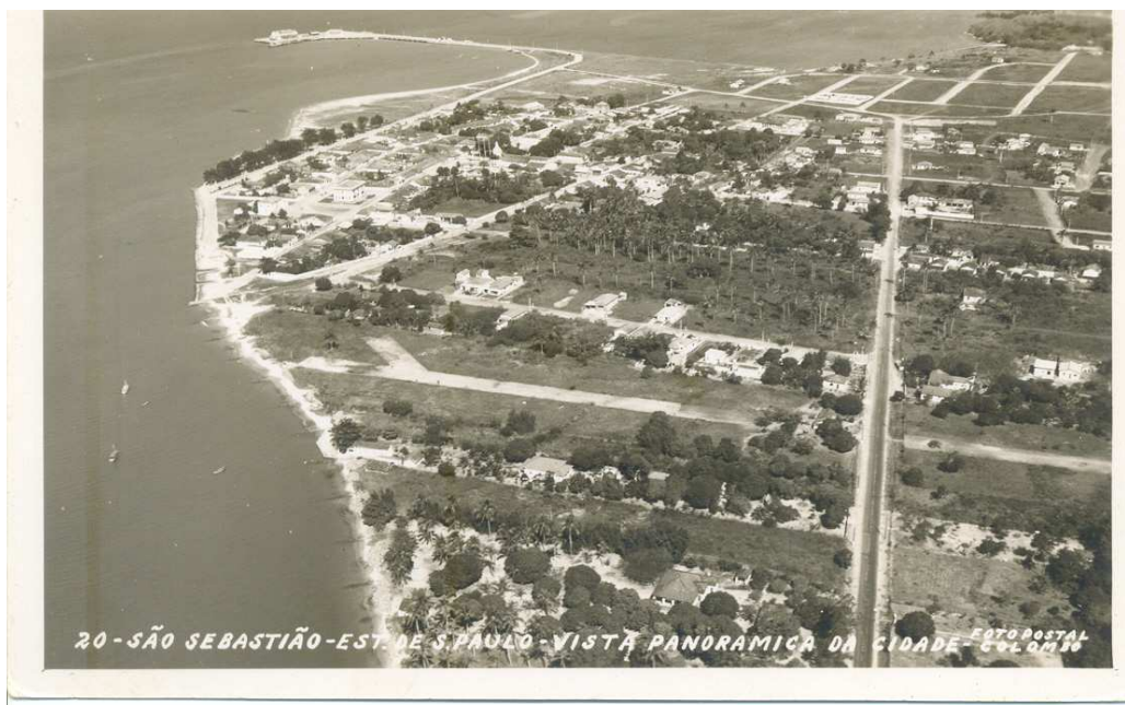
FIGURA 12: Vista panorâmica da área Central com porto ao fundo, ligado ao eixo rodoviário principal , BR 101 Ou SP 55. Dec. 60. Fonte: DPH- São Sebastião.
