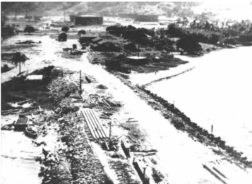
FIGURA 14: Construção do píer do TEBAR- Terminal Almirante Barroso- em São Sebastião, SP na segunda metade da dec. de 50. Fonte: Arquivo Histórico Municipal de São Sebastião.
