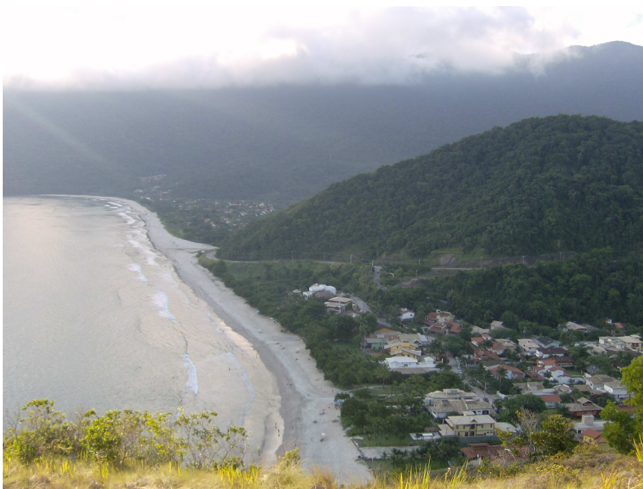
FIGURA 20: Praia de Guaecá: loteamento pioneiro da Costa Sul seguindo os padrões urbanos ditados no Plano Diretor da década de 60. Fonte: autor.
