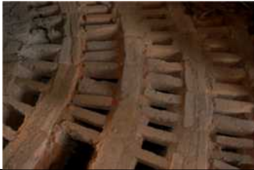
Detalhe de piso vazado no interior de um forno.
