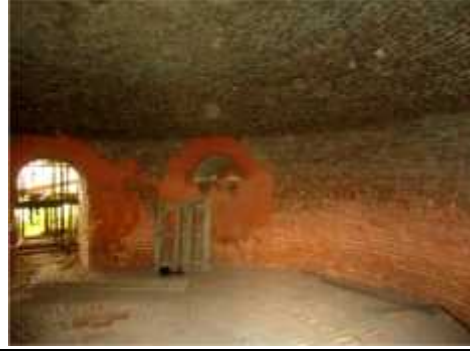
Detalhe do interior de um forno, porta e abertura para as fornalhas.
