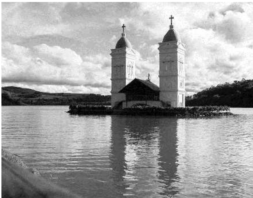
Figura 2.10 – Monumento das torres preservadas de Itá, Santa Catarina.
