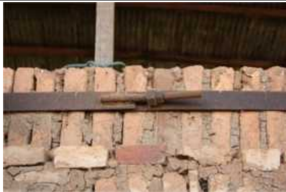
Detalhe das cintas de amarração de ferro.
