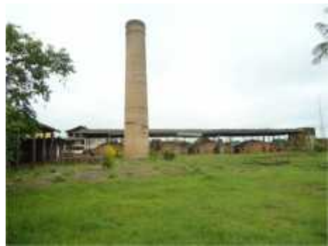
Aspecto geral de chaminé e conjunto de quatro fornos.
