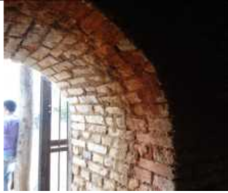
Detalhe da espessura da parede na porta.
