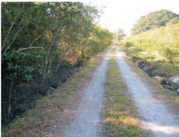
(8) A construção de estradas de manutenção para os oleodutos cria barreiras desequilibrando os fluxos de água nas áreas alagadiças. No caso dos manguezais, o impacto é mais drástico por interferir no equilíbrio da salinidade. À esquerda, mangue seco pela interrupção no fluxo de água. Foto Roberto Sakamoto, 2006.
