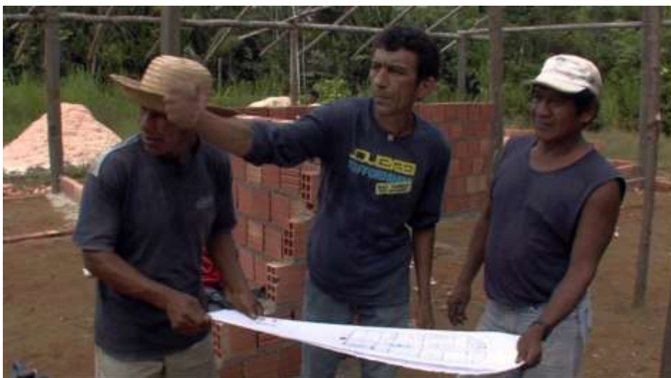
Figura 66 - Implantação e construção de um telecentro na aldeia do Balaio – AM
