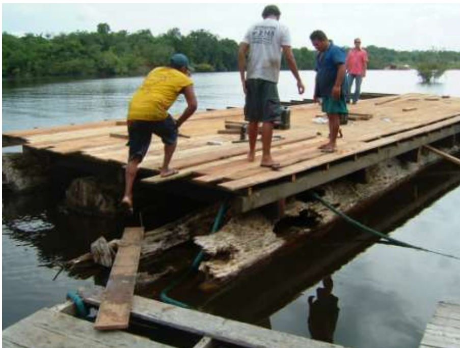
Figura 39 - Montagem da base de uma habitação flutuante como sistema de flutuação a partir de toras de assacú.
