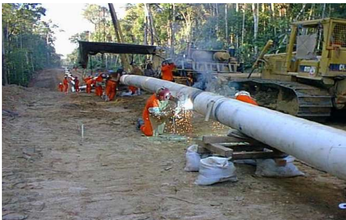
Figura 29 - Instalação de dutos de 20 polegadas em trecho de clareira do gasoduto.
