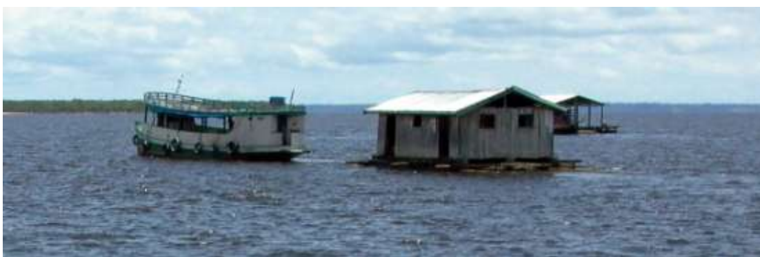
Figura 46 - Casa flutuante com cobertura em telhas metálicas
