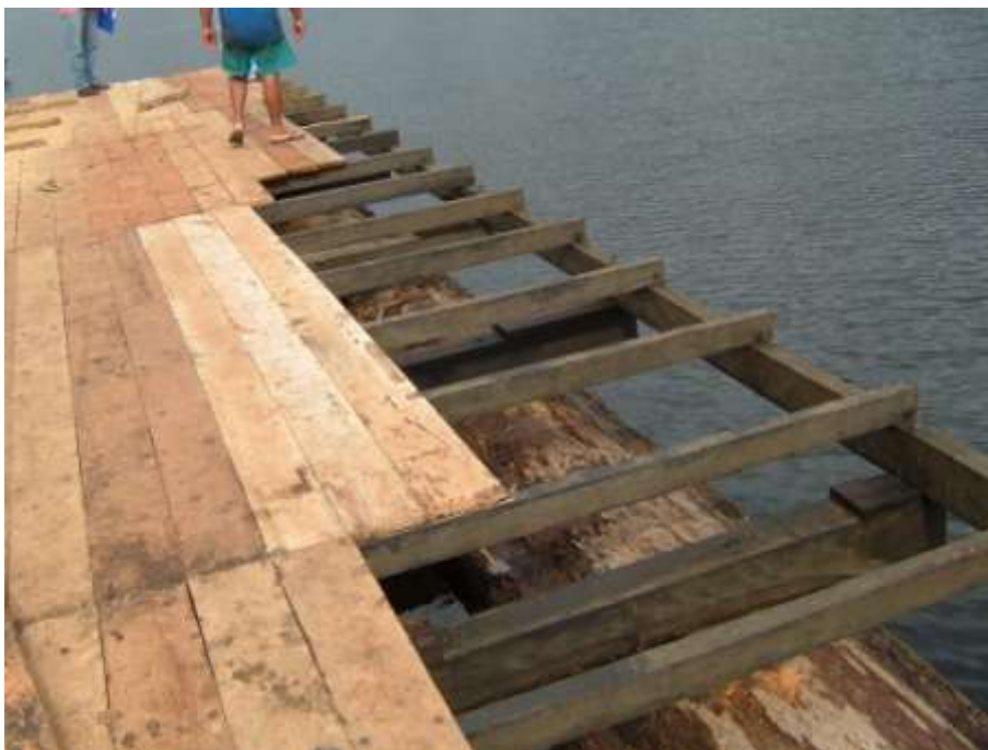
Figura 40 - Montagem da base de uma habitação flutuante como sistema de flutuação a partir de toras de assacú – Sistema de montagem das vigas
