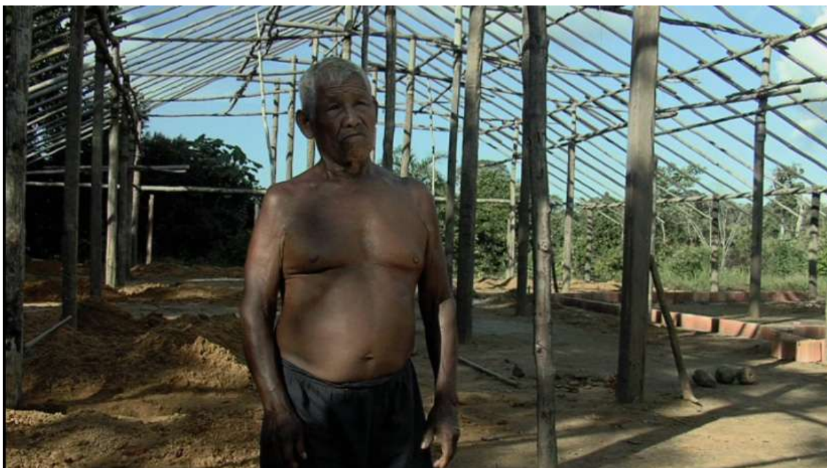
Cacique Tukano em frente à construção do centro comunitário
