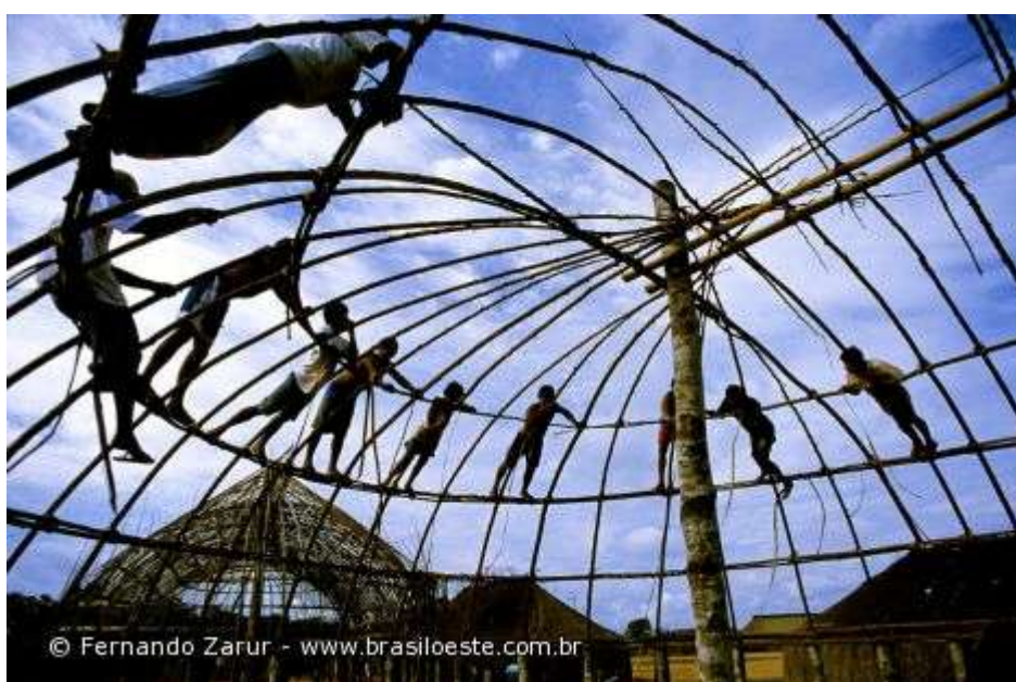
Figura 13 - Sistema de amarração executado pelos homens da aldeia, fixando a estrutura de madeira “costelas” da casa com cascas de imbirá (usado também para a confecção de artesanatos).
