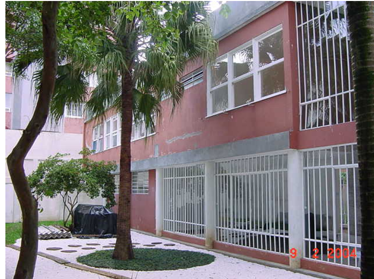
Pintura da fachada externa
