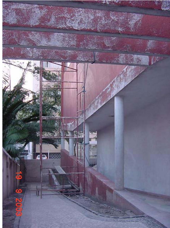
Recuperação das alvenarias, lavagem e preenchimento das alvenarias com argamassa
