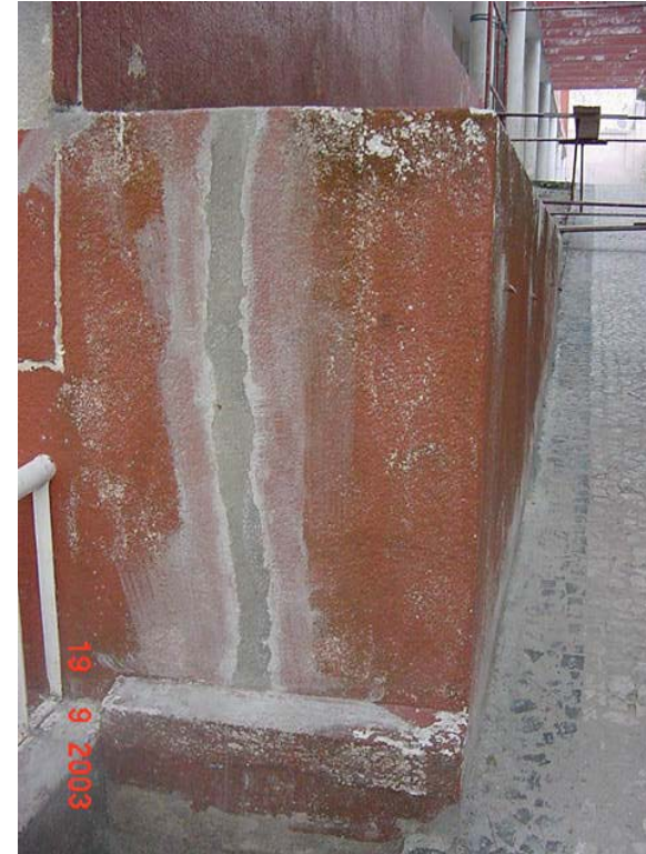
Recuperação das alvenarias, lavagem e preenchimento das alvenarias com argamassa
