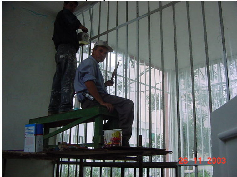
Pintura das esquadrias
