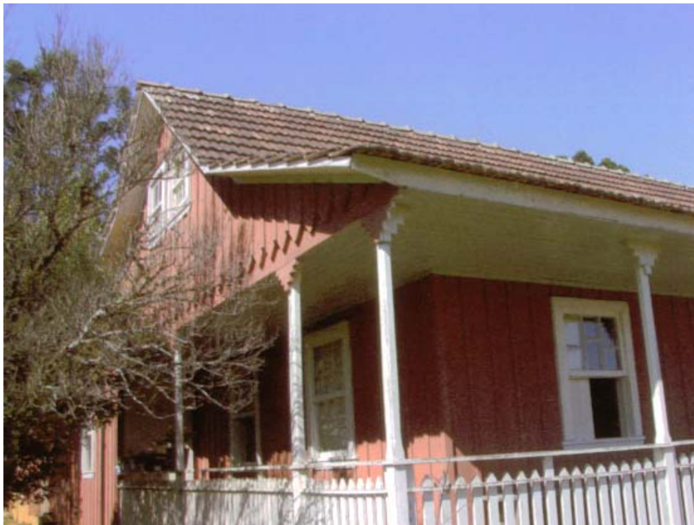
Figura 11 – Casas de Madeira com alpendre e entrada lateral
