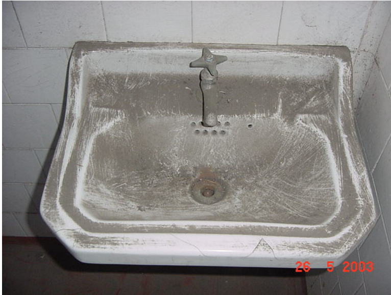
Pia do banheiro das dependências de empregada
