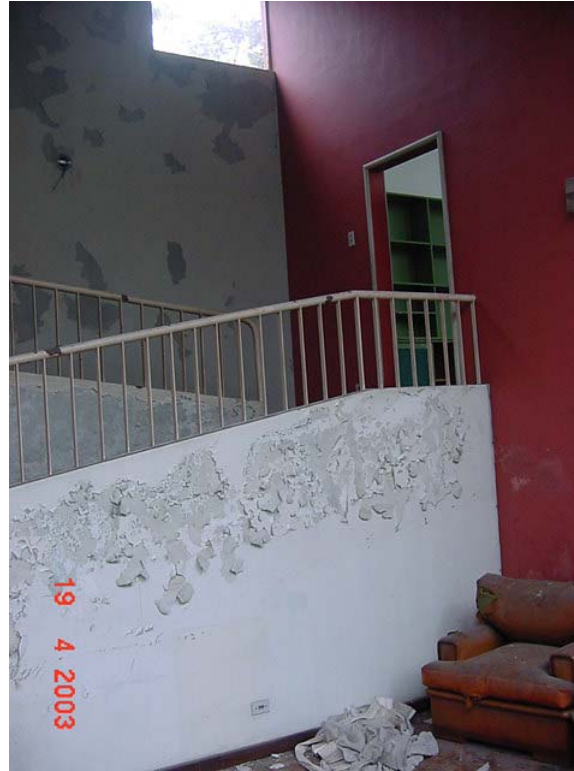
Parede da sala da lareira e da rampa
