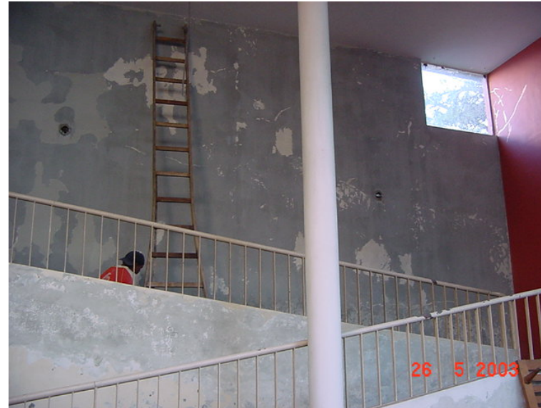
Lixamento e pintura das paredes internas
