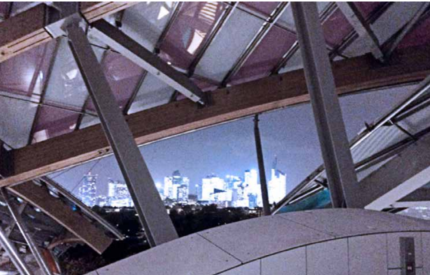
Fondation Louis Vuitton Projeto de Frank Gehry Vista interna das estruturas Paris, FR, 2013 Fotos do autor, 2016
