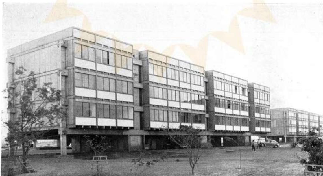
Artigo sobre os Alojamentos de Professores, da Universidade de Brasília, construídos em elementos pré-fabricados de concreto.
