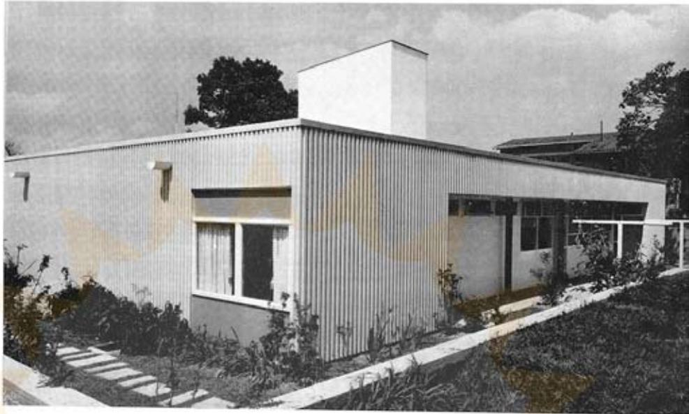
Esta residência foi proposta ao arquiteto pela própria fábrica, visando, em caráter experimental, um protótipo de habitação industrializável. A precisão requerida na produção dos montantes de madeira que servem à fixação dos painéis, dificultou ao extremo a execução da obra. Dela surgiram porém, por proposta do arquiteto, os atuais painéis "sanduiche" da Eternit, além da já famosa placa corrugada (como mostram os detalhes).
