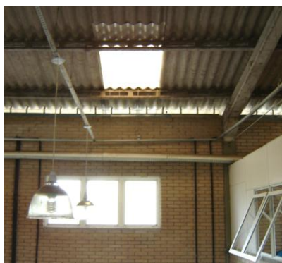
Figura 70 – Teto permite a circulação do ar e a passagem de luz natural
