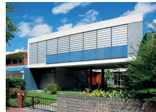
Figura 42. Casa Muras Giraldi. O. Muras, H. Giraldi Fonte: I. de Montevideo (2014)
