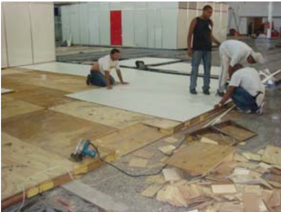
imagem 2-59 Pallets colocados é hora dos acabamentos
