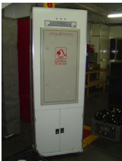
imagem 2-29..... Locais de armazenamento Empresa Arquitrama
