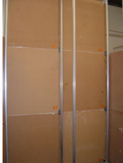
imagem 2-46 Galpão de pré-Montagem Empresa Arquitrama
