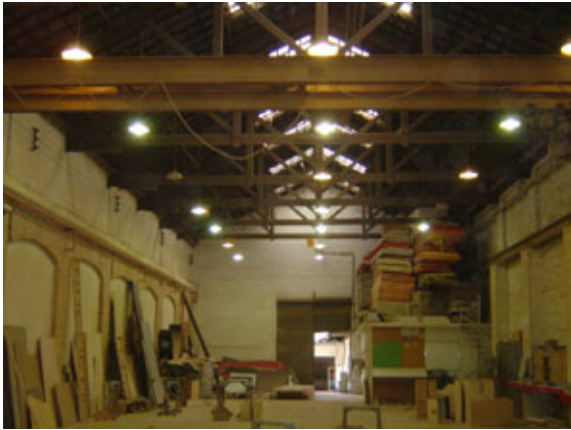
imagem 2-1 Galpões e oficinas Empresa Arquitrama
