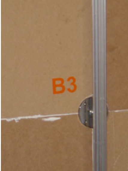
imagem 2-45..... Galpão de pré-Montagem Empresa Arquitrama
