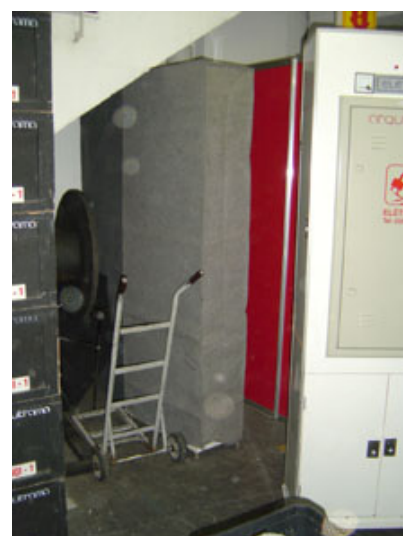
imagem 2-31..... Locais de armazenamento Empresa Arquitrama
