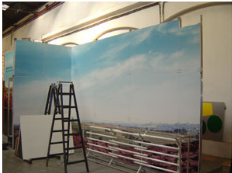
imagem 2-44 Galpão de pré-Montagem Empresa Arquitrama
