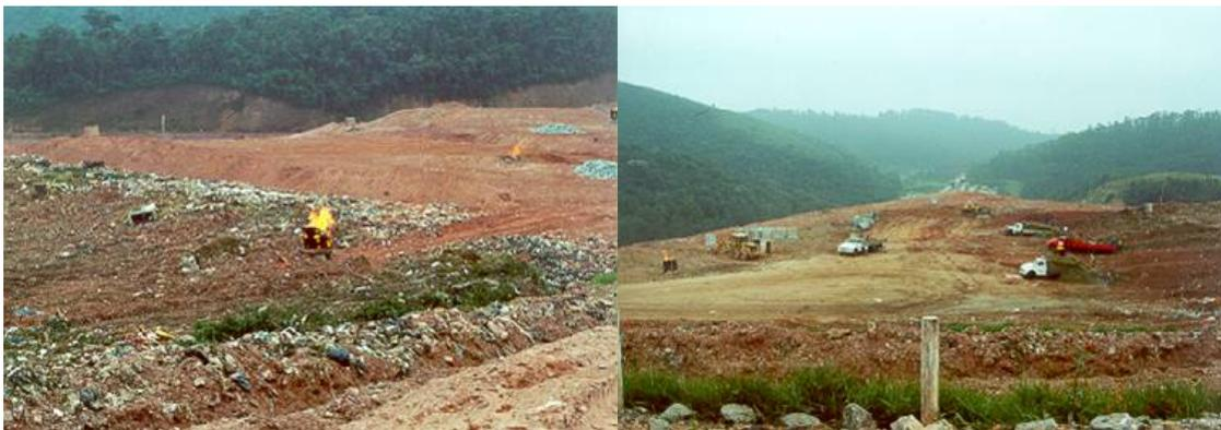
Figuras 10.7 e 10.8 – Aterro São João – detalhe do *flare* queimando os gases e pátio de descarga de resíduos – 2002
