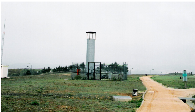
Figura 4.6 – Queimador de gases no antigo aterro de Loures – Portugal – 2004 Foto: Claudia Ruberg.
