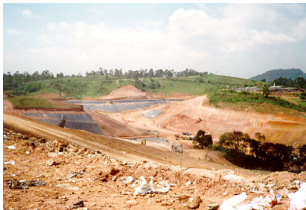
Figura 4.1 – Vista da manta de impermeabilização – aterro Bandeirantes – São Paulo – 1996 Foto: Claudia Ruberg.
