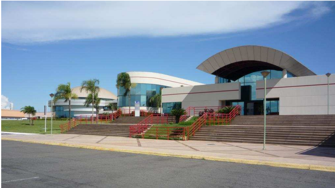
Ilustração 13 - Foto da Fachada Principal do PqTec-SJC FONTE: A AUTORA (2013)
