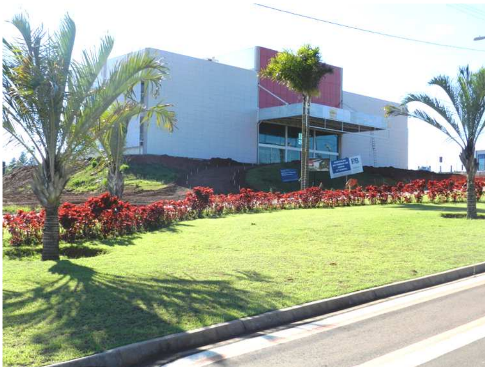
Ilustração 11 - Sede do núcleo do parque, em 2014, abrigando o Instituto Inova, incubadora, auditórios e o centro de inovação. Em destaque a parede térmica do prédio.
