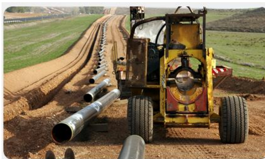
Ilustração 31 - Montagem de dutos
