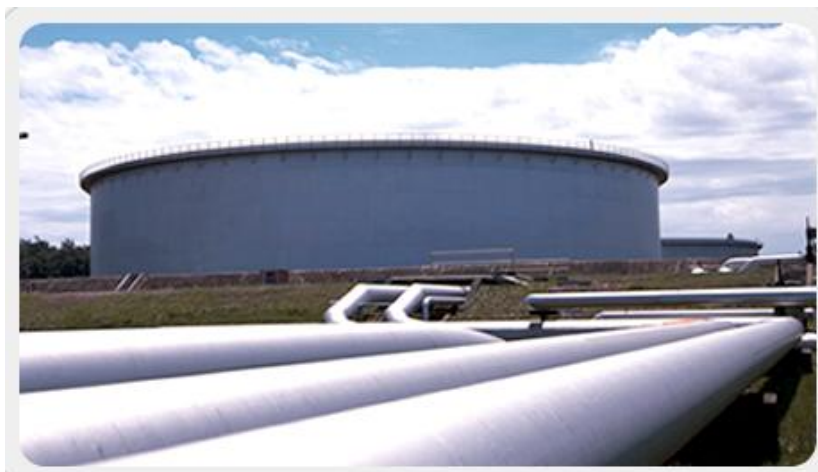
Ilustração 29 - Tanques de armazenagem de etanol
