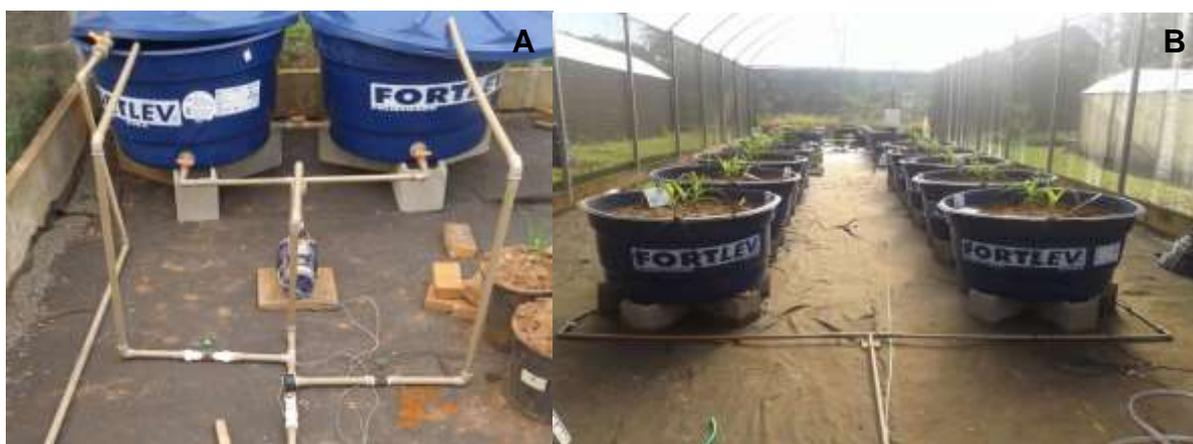
Figura 15 - A) Reservatórios para preparo da fertirrigação e armazenamento de água; B) Derivação da linha principal para duas linhas secundárias de irrigação
