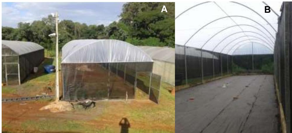
Figura 3 - (A) Ambiente protegido empregado para condução do experimento de extração de água no solo pela cultura do milho e (B) interior da casa de vegetação com o solo coberto por manta geotéxtil.
